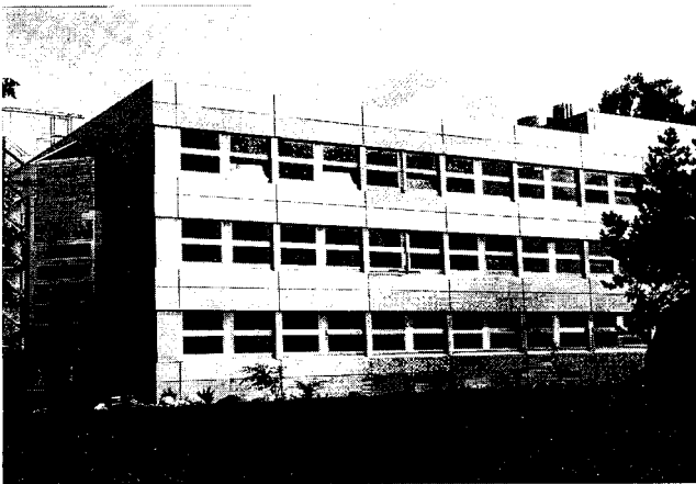
Der Erweiterungsbau an der Veterinärmedizinischen Fakultät im Areal des Tierspitals.
